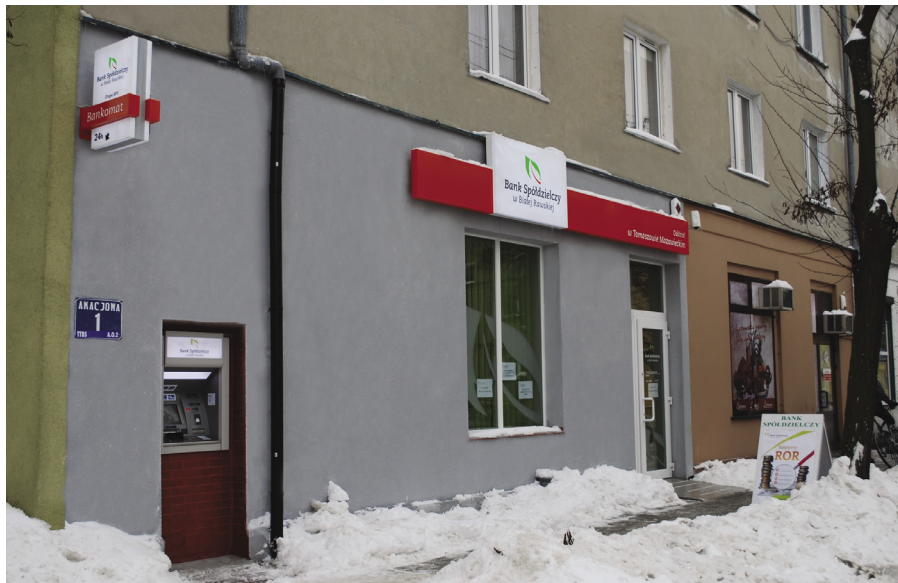
Siedziba Oddziału w Tomaszowie Mazowieckim przy ulicy Akacjowej 1
